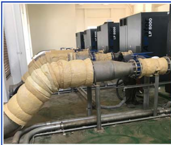
鼓風機管路玻璃棉防火保溫工程
