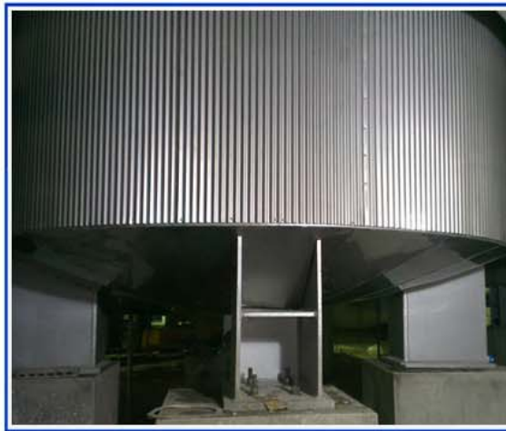
桶槽設備保溫外覆不鏽鋼小圓浪板板金
