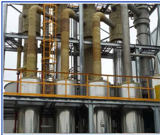
管線設備岩棉隔熱外覆不鏽鋼板板金
