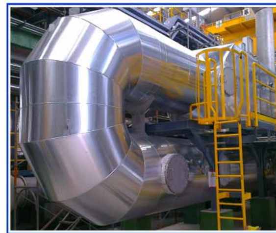
機械設備保溫外覆鋁皮板金
