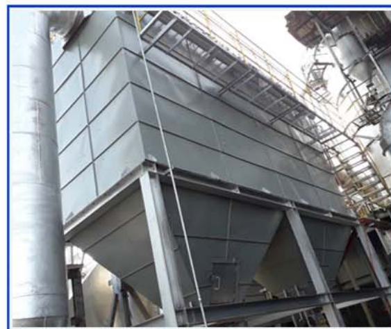
集塵設備保溫外覆烤漆板板金工程
