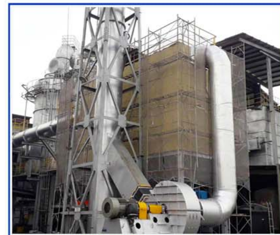
集塵設備岩棉防火保溫施工
